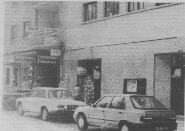
Em plena Av. Dr. Lourenço Peixinho, no centro da cidade, as nossas instalações.
