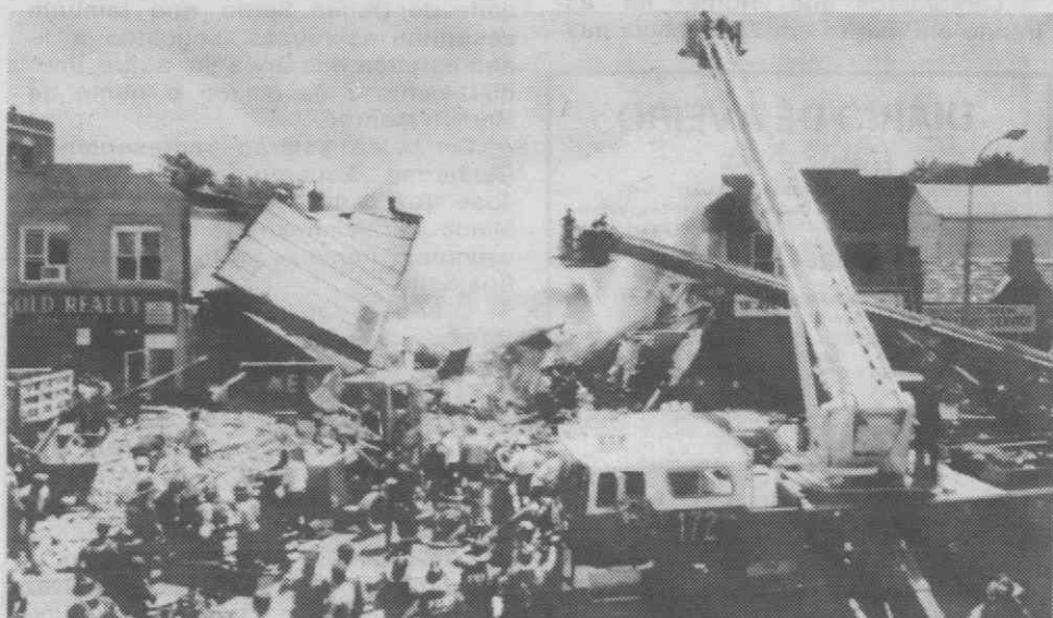
NOVA IORQUE — Aspecto das destroças dum edifício que se desmoronou, provocando 3 mortos e 4 feridos graves.
