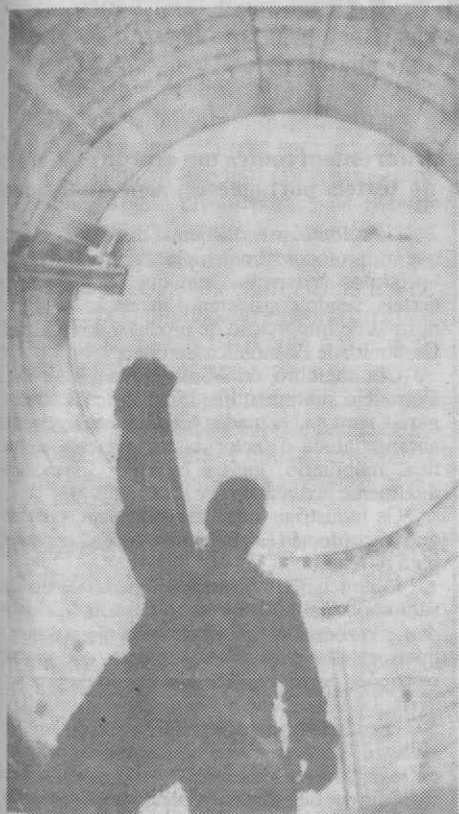
CALAIS (França) — Construção do túnel entre Calais e a Grã-Bretanha.
