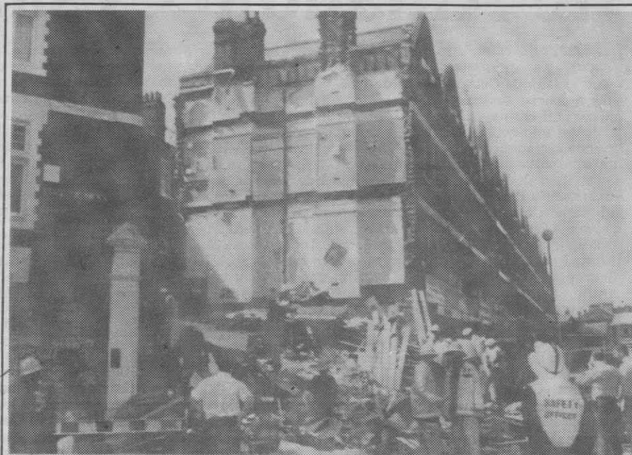
LONDRES — Aspecto dos estragos causados pela explosão de gás num prédio que causou um morto e catorze feridos.
