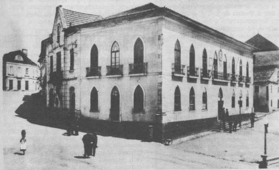
O antigo edifício dos Paços do Concelho de Águeda.
