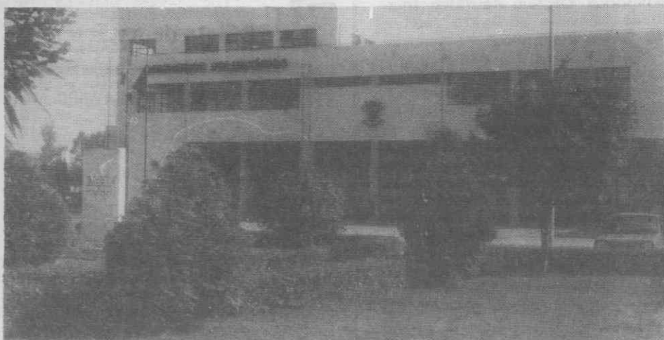
O novo Quartel dos Bombeiros de Vagos.
