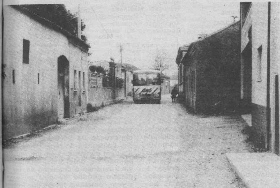
Para quando a pavimentação do troço de Travassô da EN 230?
