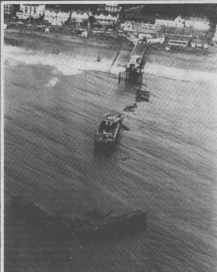
ILHA DE WEIGTH — Vista aérea do porto de abrigo completamente destruído em consequência dos fortes ventos que se fizeram sentir.
