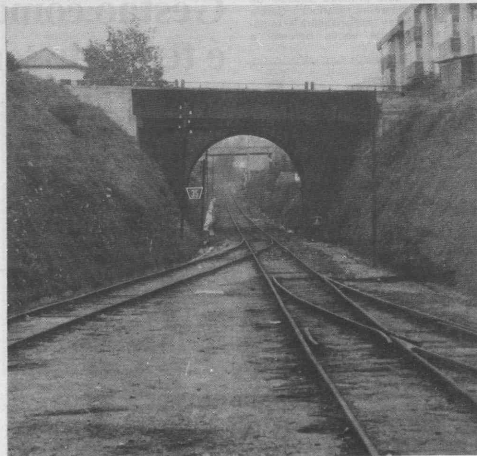
O recomeço das obras, de alargamento do pontão poderá estar para breve.
