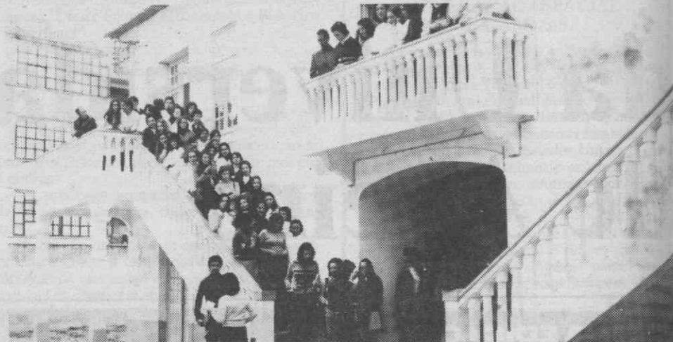
1973-74 — O corpo principal da EMPA, a dar para o pátio.
