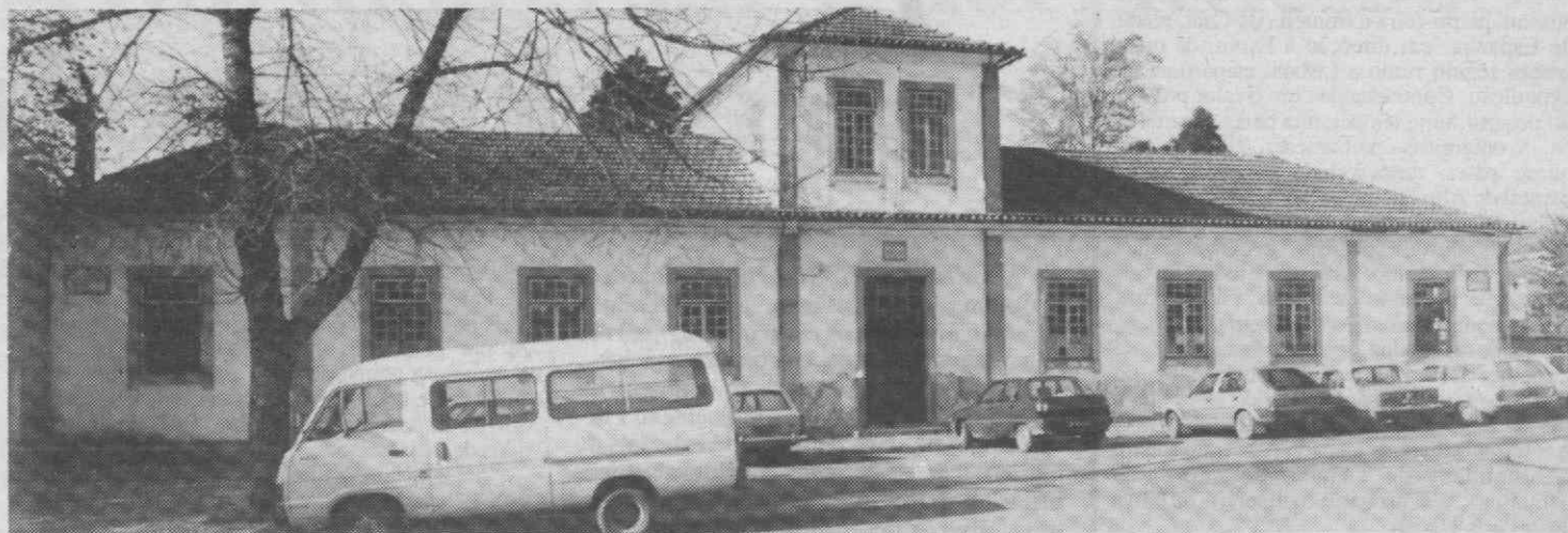
As obras de remodelação da Escola do Adro vão iniciar-se em breve.
