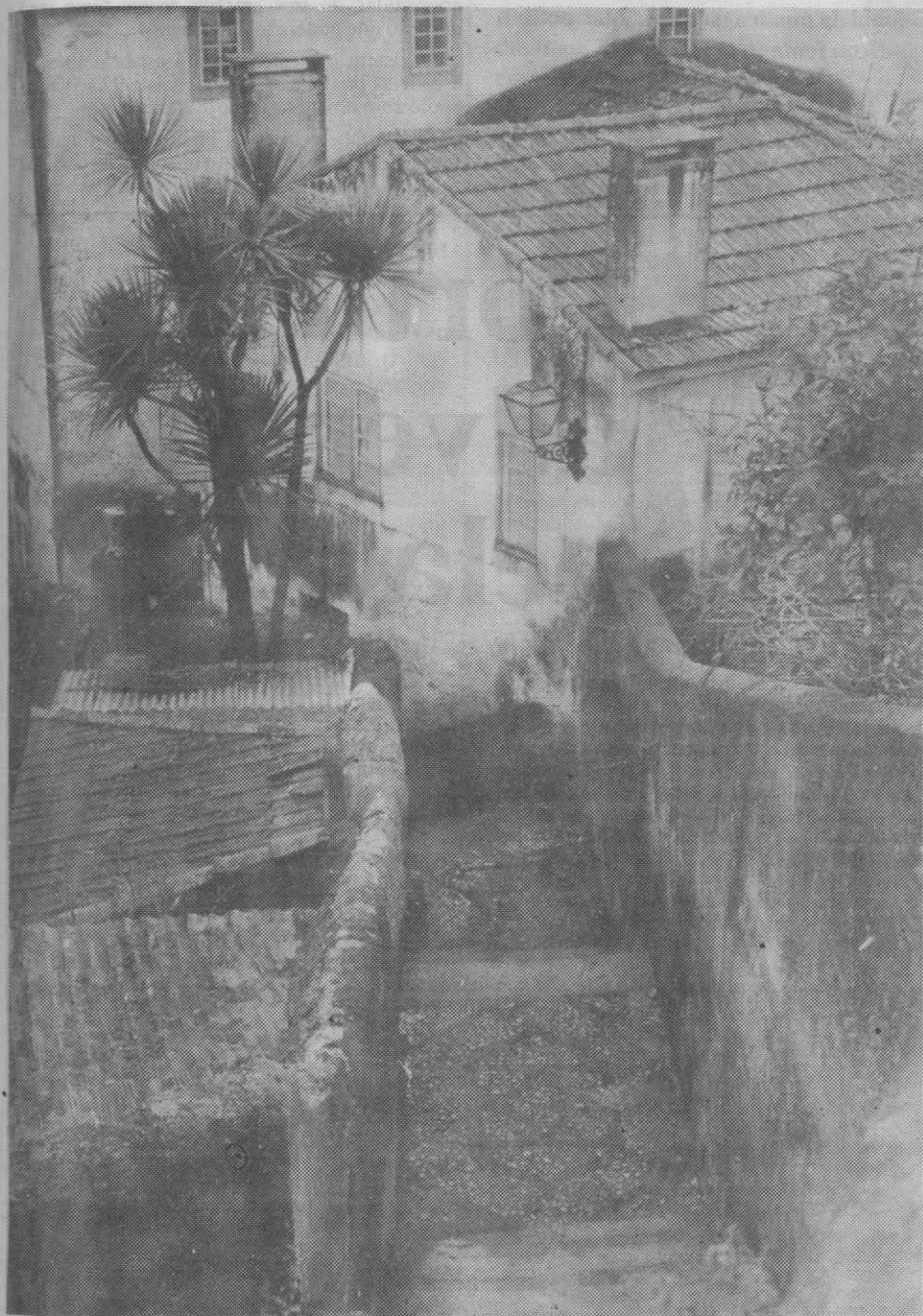
Um aspecto da escadaria do adro.
