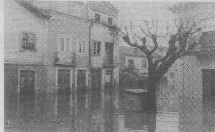
Alguns edifícios ficaram isolados pelas águas. Na imagem, um armazém situado junto da Estrada do Sardão.
