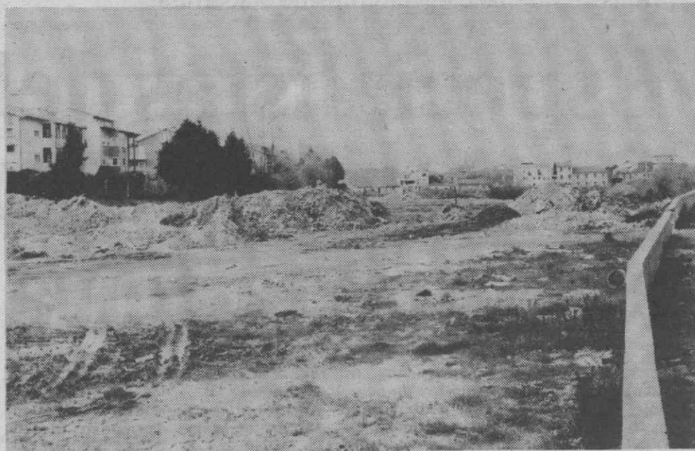
Aspecto dos trabalhos de terraplanagem da Baixa de Santo António.
