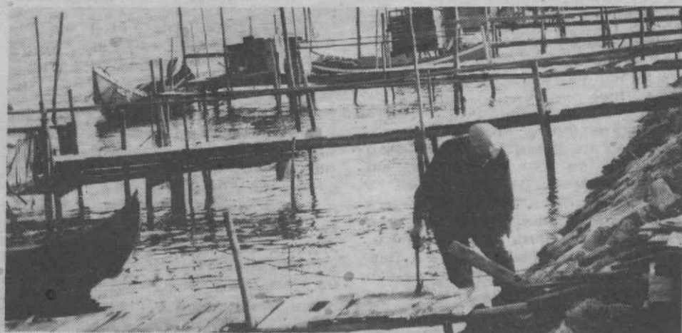
São estas «passareles» de madeira fincadas nas águas que servem de cais aos pescadores.
