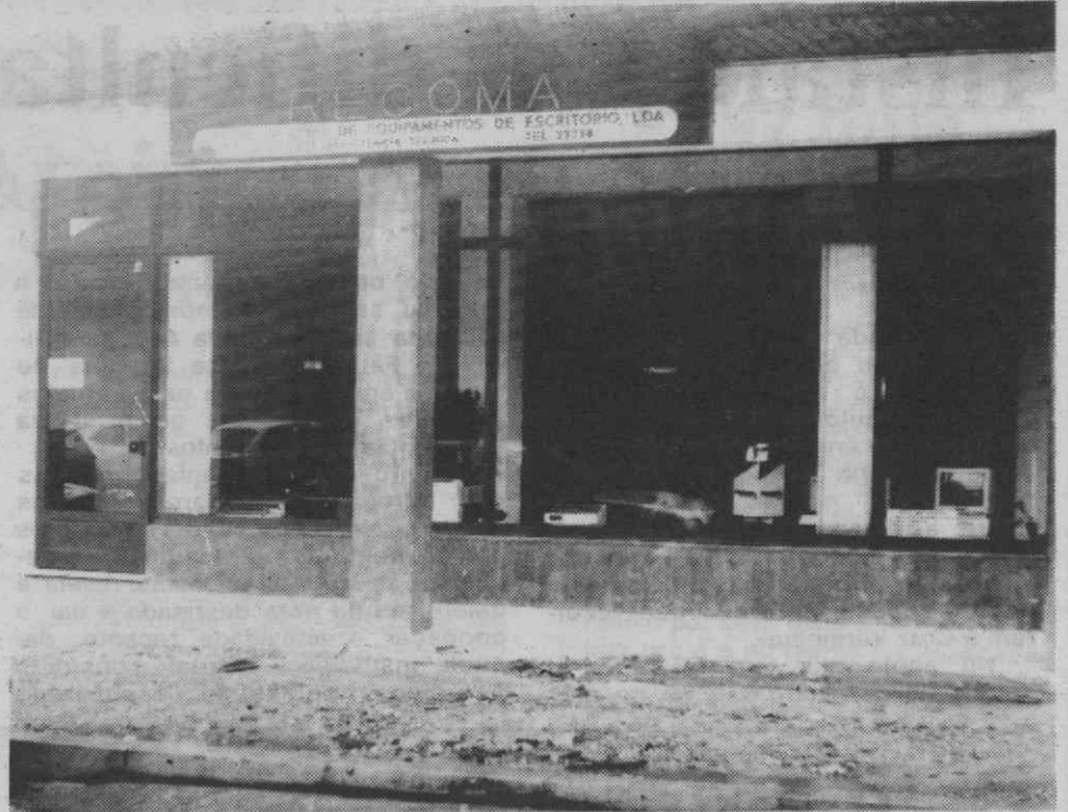
A fachada do prédio onde se têm verificado as sucessivas inundações.
