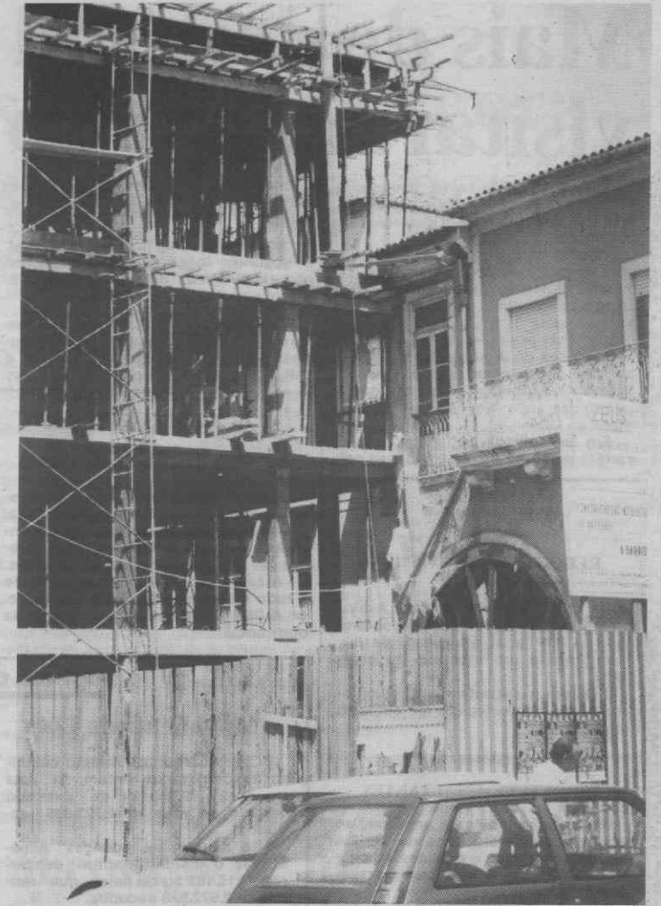
Aspecto da construção da Cooperativa de Artesãos «A Barrica».
