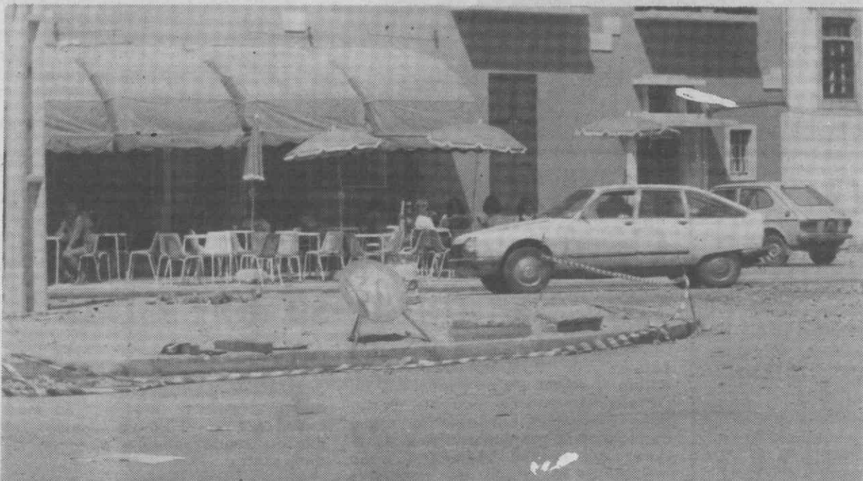
Na Praia da Barra os turistas (e os comerciantes) queixam-se das obras efectuadas. A verdade é que as pedras soltas na estrada atingem os veraneantes que se encontram nas esplanadas. Um mau cartaz turístico que poderá ter reflexos negativos, no futuro.
