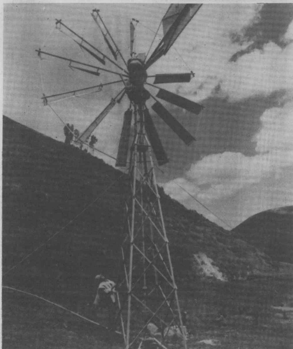
O aproveitamento de energias regeneráveis prevê um trabalho intenso no desenvolvimento conjunto de técnicas.
