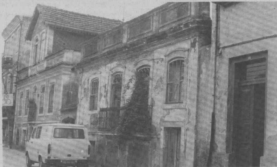
Este é um dos imóveis que ameaça derrocada.
