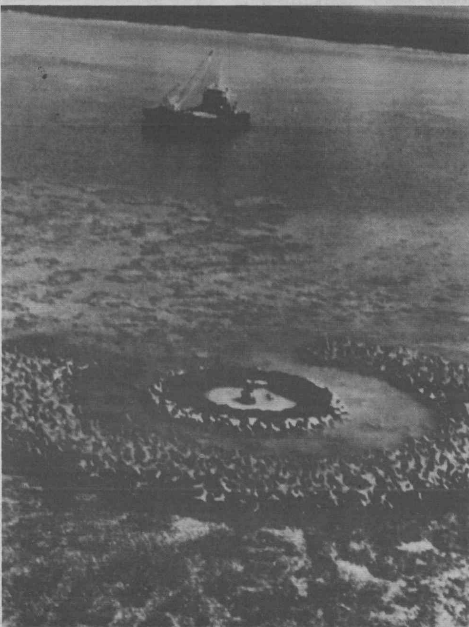
OKINOTORI-SHIMA — Nesta fotografia aérea podemos observar a construção de dois círculos à volta da pequena ilha de Okinotori-Shima, Japão, que evitarão a erosão das ondas marítimas. O Japão tem grande interesse na manutenção desta pequena ilha a fim de não ver diminuída a sua Zona Económica Exclusiva.
