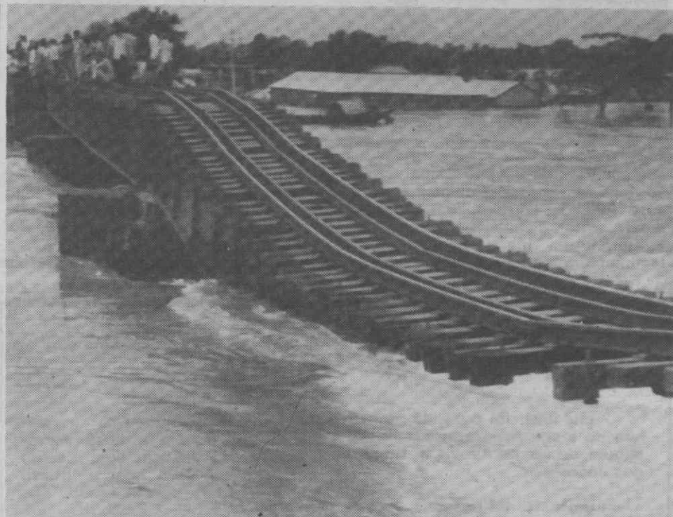
TONGI (Bangladesh) — A maior ponte ferroviária do país semi-submersa após os pilares que a sustentavam terem cedido.
