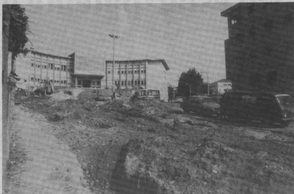
A obra de remodelação da Rua Fernando Caldeira, em conjunto com a construção da rede de saneamento básico, foi adjudicada pela importância de 21 mil contos.
