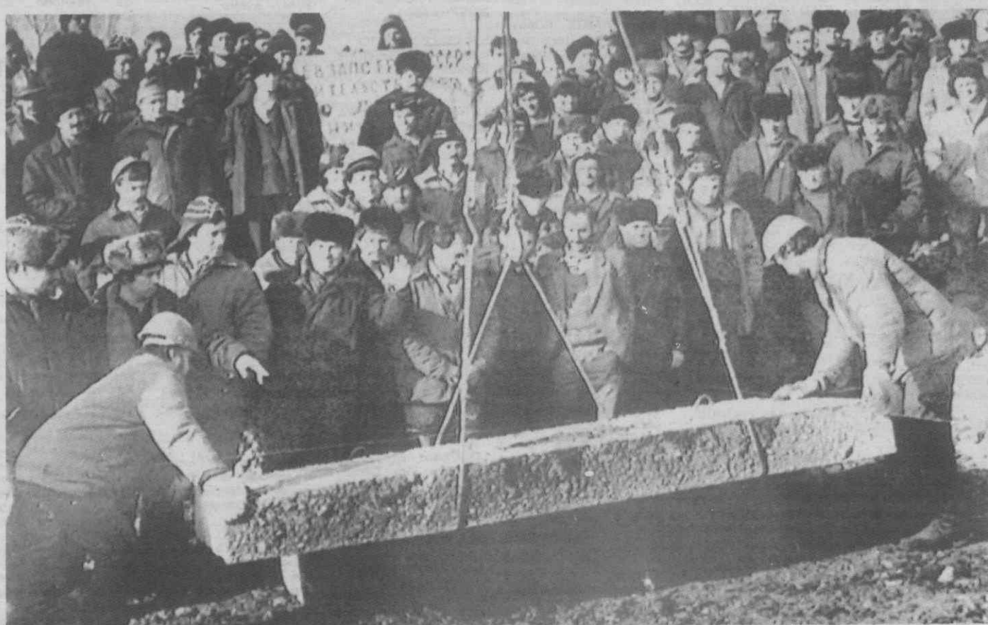
LENINAKAN (ARMÉNIA) — Dezenas de arménios assistem à colocação de uma pedra para as fundações de uma nova casa.
