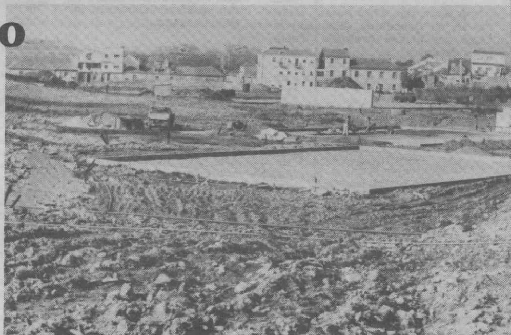
Obras na Baixa de Santo António, prolongamento de uma zona verde no coração da cidade.
