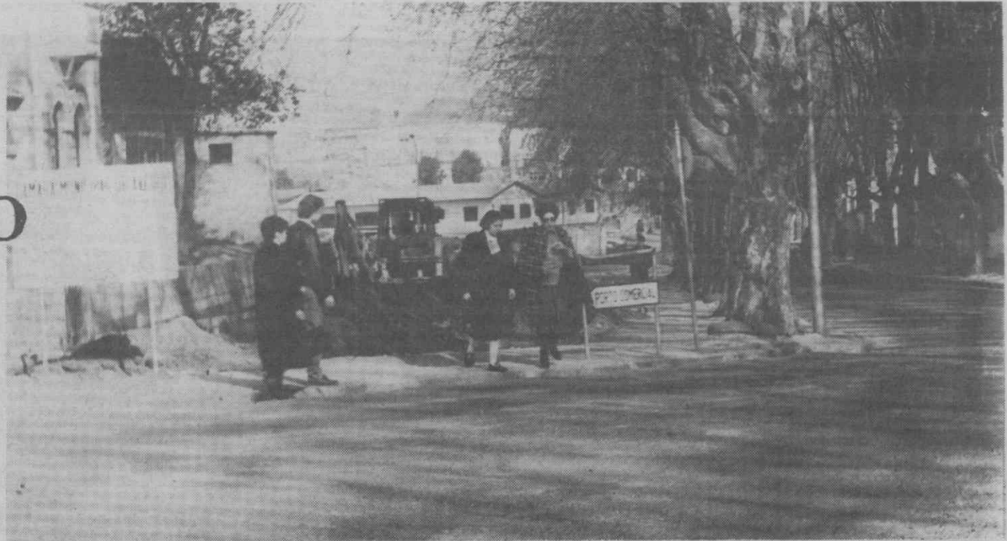
Aspecto do início da construção da Av. Central.
