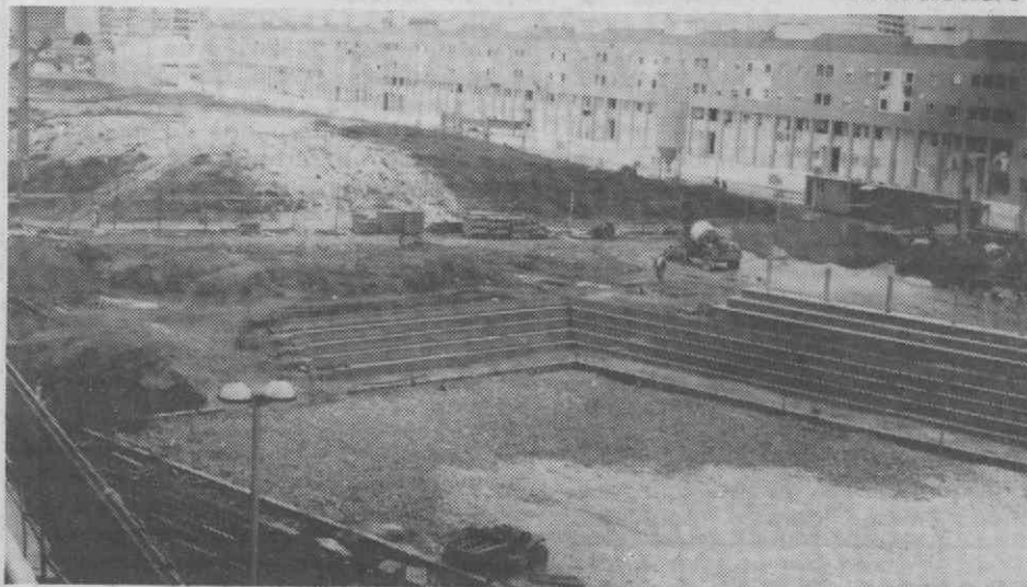
Aspecto de um dos dois polidesportivos a construir em Santiago.
