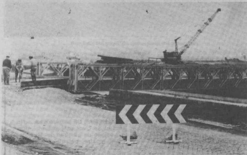
Aspecto da montagem do pontão sobre o Canal Central.
