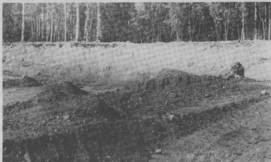
O tamanho e a profundidade das escavações parecem indicar que ali será edificada uma cidade de arranha-céus. Milhares de metros cúbicos de saibro foram retirados à terra, sem que, aparentemente, se tivessem procedido às necessárias diligências estipuladas por lei. Todavia, a saída para este caso parece ser a do facto consumado.
