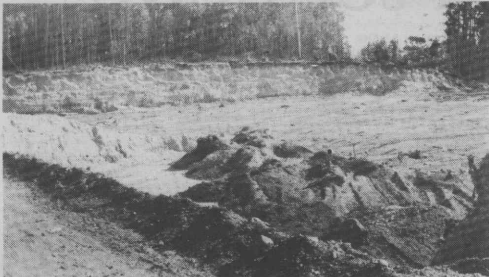
No lugar do Carregal, freguesia de Requeixo, várias crateras, algumas com uma profundidade superior a dez metros, são as marcas, bem visíveis, da exploração de saibro.
