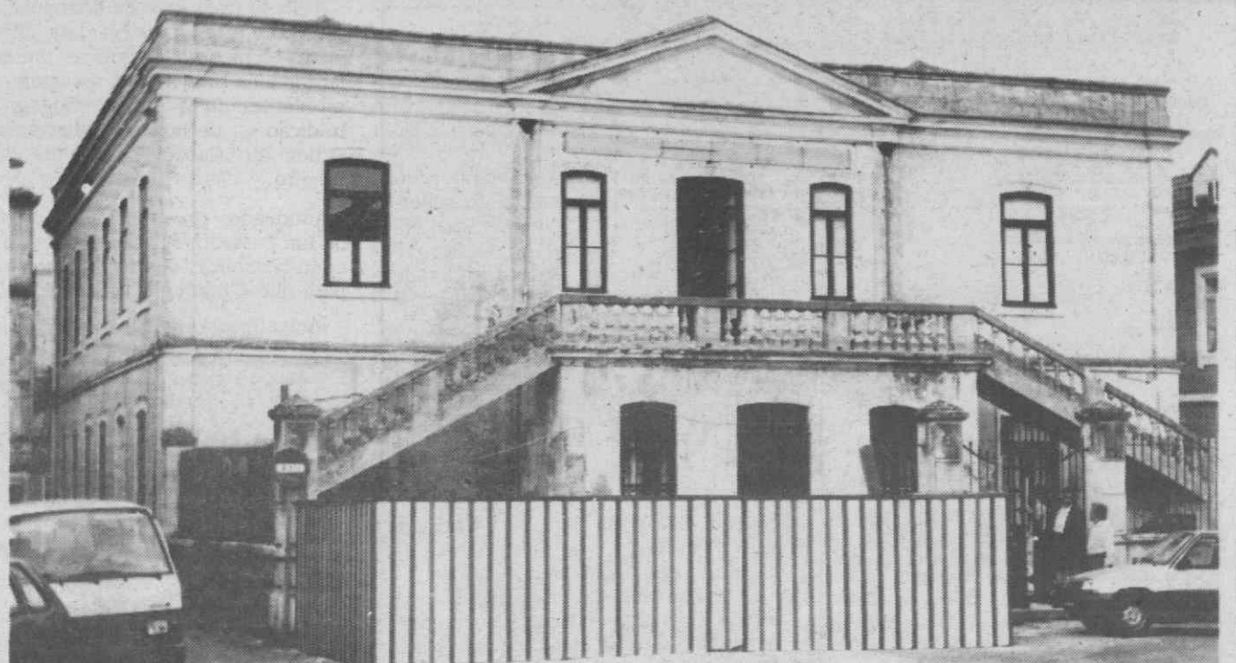
Do antigo edifício serão aproveitadas as paredes exteriores referentes aos alçados principal, lateral direito e lateral esquerdo. Quanto à parede do alçado posterior será demolida para dar lugar à outra, mas procurar-se-á salvaguardar a escadaria.
