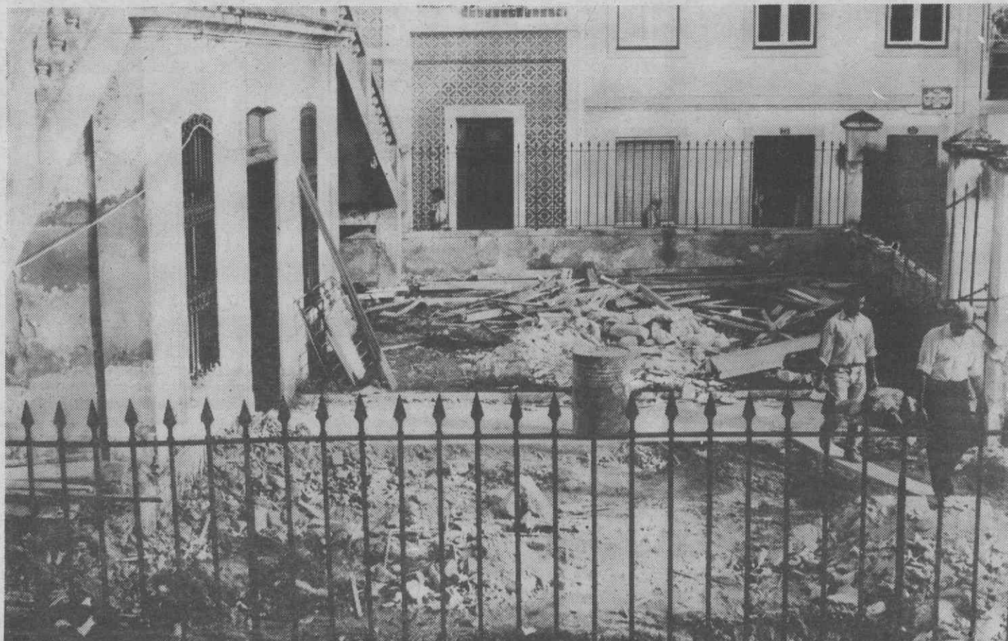
As obras prosseguem. Espera-se que o prazo estabelecido para a conclusão dos trabalhos de recuperação e adaptação seja cumprido. Está em causa a renovação de um edifício a preservar.
