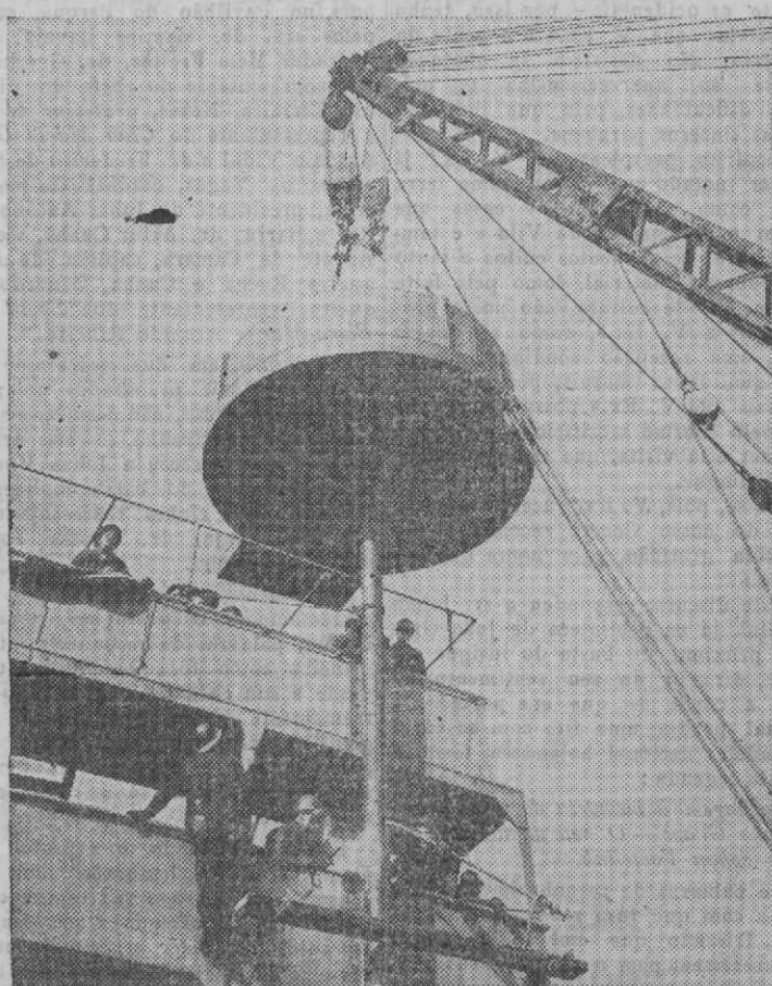
UM PODEROSO GUINDASTE TRANSPORTA UMA COURAÇA PARA PROTEGER AS METRALHADORAS QUE SERÃO COLOCADAS NO CONVÉS DO NAVIO MERCANTE
