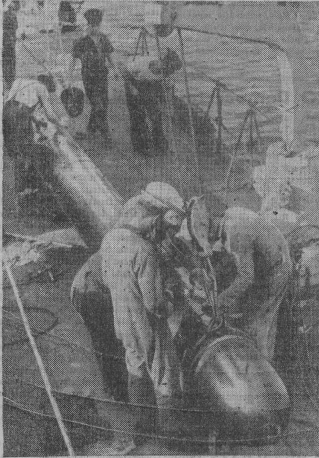
UM TORPEDO PRESTES A OCUPAR O SEU LUGAR, A BORDO DE UM CONTRA-TORPEDEIRO INGLÊS DE UMA FORÇA NAVAL
