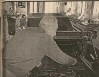
Tipografía manual, con máquina plana adaptada electricamente desde 1973
